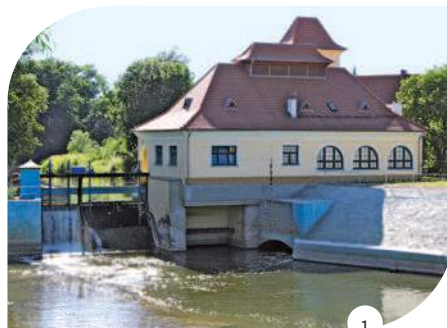
fort. 1. Elektrownia wodna w Marszowicach
